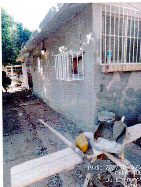
ENJARRE EN MURO EXTERIOR DEL CETRO
