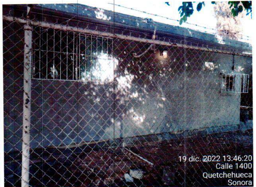
ENTRADA PRINCIPAL E IMAGEN DONDE SE APRECIA LOS TRABAJOS DE ENJARRE EN MURO EXTERIOR
