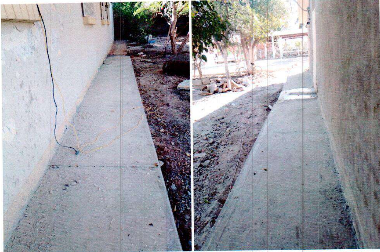
EJECUCION DE COLADO DE BANQUETA ALREDEDOR DEL CENTRO
